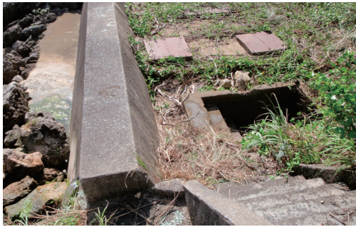
図6. シゴの全景。護岸右側の水汲み場の奥にコンクリートのタンク天板と2つの鉄板のふたが見える。水汲み場の左側には排水している状態が見える。
