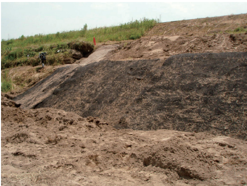
図8. 浸食防止シート（上）と法面張付け工事（下）.
