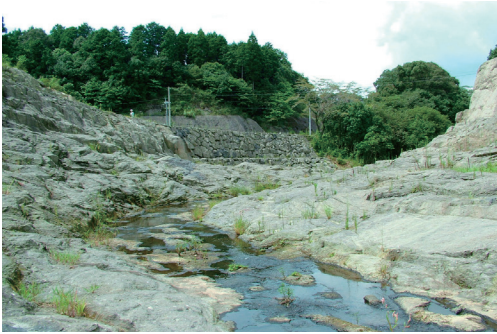
図4. 分水路内の状況。
